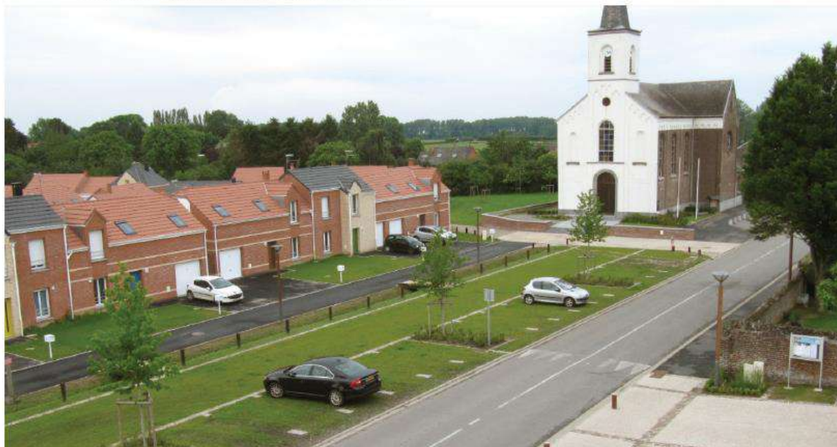
Exemple de réalisation d'une place verte en mélange terre-pierre accueillant au quotidien stationnement et ponctuellement fêtes foraines -Réalisation Bocage-Epure Paysage commune de Bettignies
