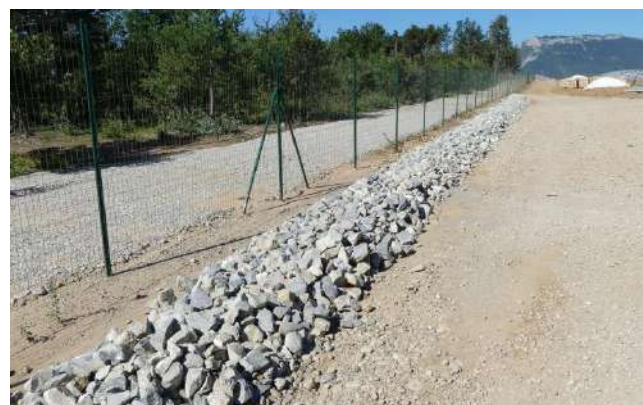
Merlon de filtration des eaux de ruissellement et des fines – DRYOPTERIS 2017
