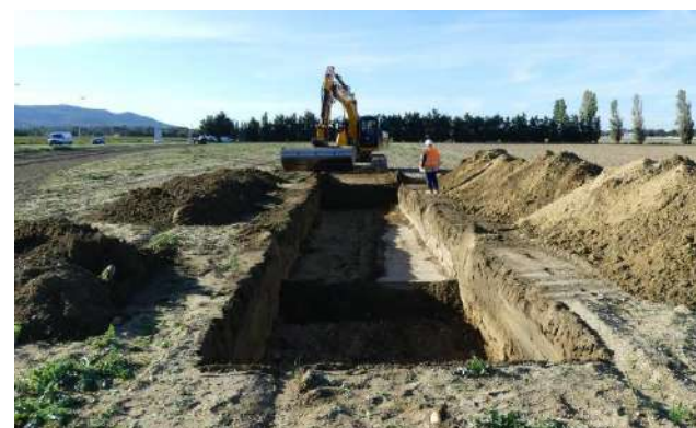
Exemple : la terre végétale est dissociée du sol profond lors du creusement des fouilles (à gauche), puis les horizons sont repositionnés dans leur ordre naturel (à droite). DRYOPTERIS, 2017
