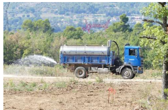
Humidification des pistes d'accès à l'aide d'un camion-citerne
