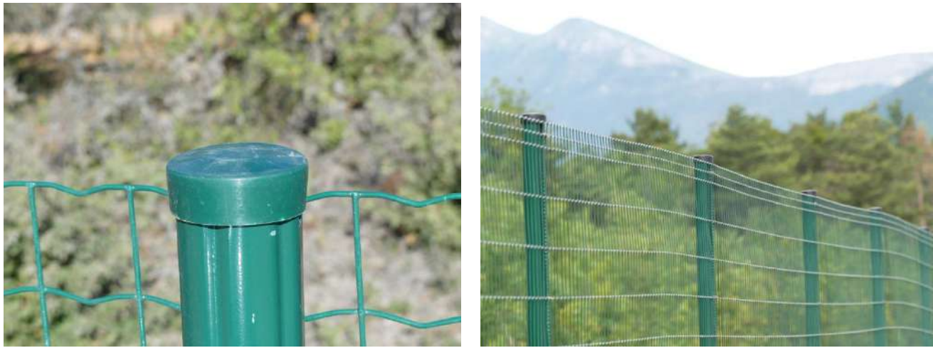
Exemples de clôture dont le sommet des poteaux a été obstrué – DRYOPTERIS, 2017
